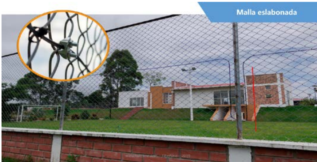
Figura 6a. Instalación en malla eslabonada
