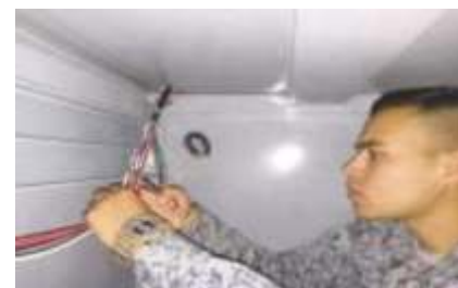
Figura 18. Observando y probando voltaje de Cableado
