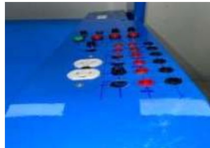
Figura 28. Ajustes, acoples y verificación de conexiones
