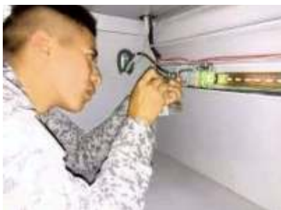
Figura 26. Remoción Sistema eléctrico
