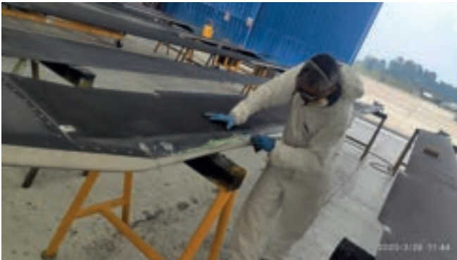
Fig.4 Procedimiento de instalación de la cinta de titanio
